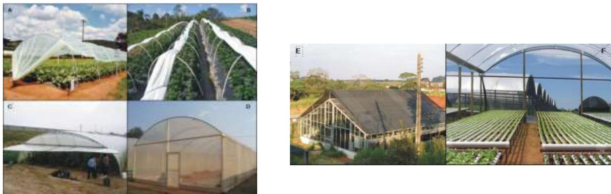
Figura 1. Túnel alto (A), túnel baixo (B), estrutura sem pé-direito (C) estrutura com pé-direito (D), casa-de-vegetação (E) e estrutura hidropônica tipo NFT dentro de ambiente protegido (F).
